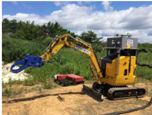
図 4. タフ・ロボティクス・チャレンジで開発した建設ロボット
